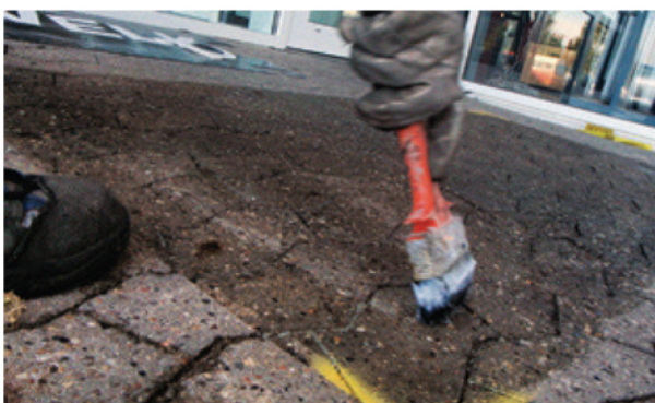
Vær omhyggelig med kun at påføre primer indenfor det markerede område, da primer misfarver underlaget. Lad det tørre ca. 20 minutter før symbolet igen placeres.
