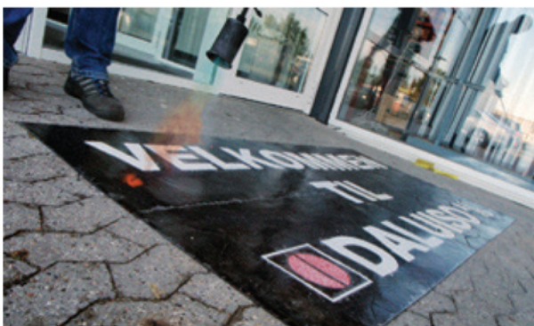
Opvarm symbolet med en gasbrænder til termoplasten er flydende og bobler op. Brug rolige og jævne bevægelser, så termoplasten ikke brænder.
